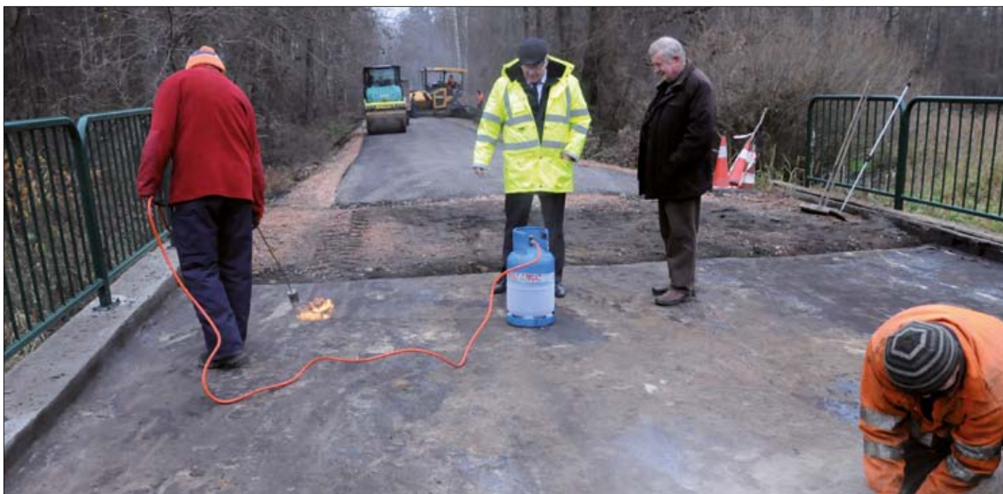
Remont mostu na drodze w Zwierzyńcu.
